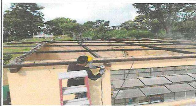
Foto 2: Mantenimiento de estructura de soporte de metal (costaneras de cocina) lijado, cepillado y aplicación de pintura.
